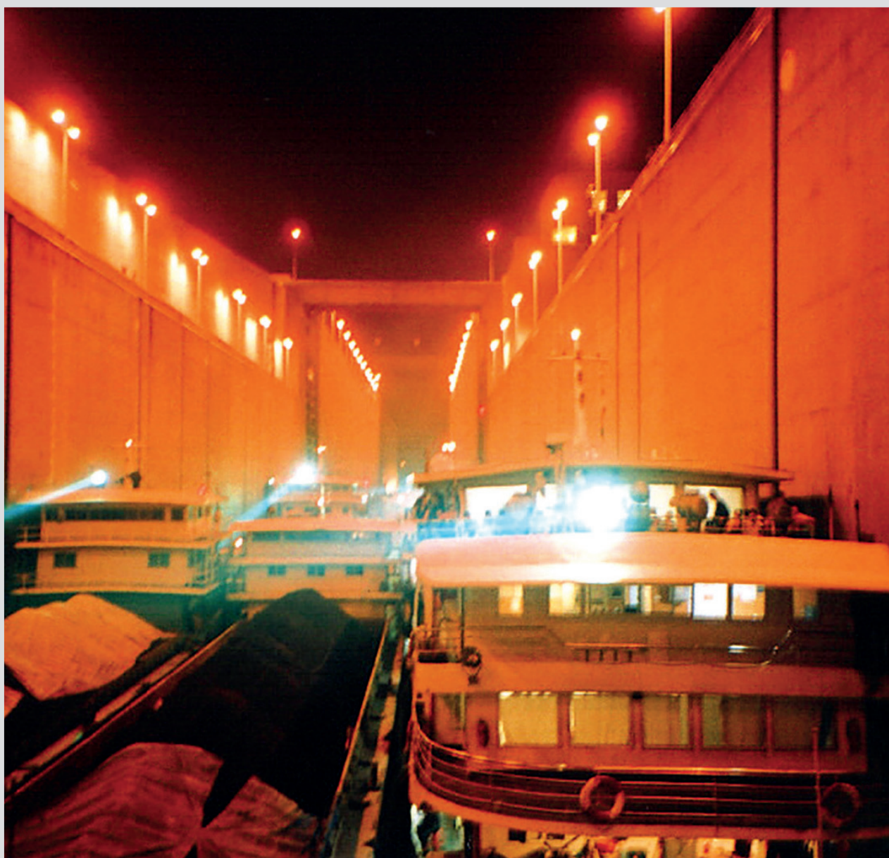
▲ Obr. 29: Plavební komory zdymadel na Třech soutěškách.
