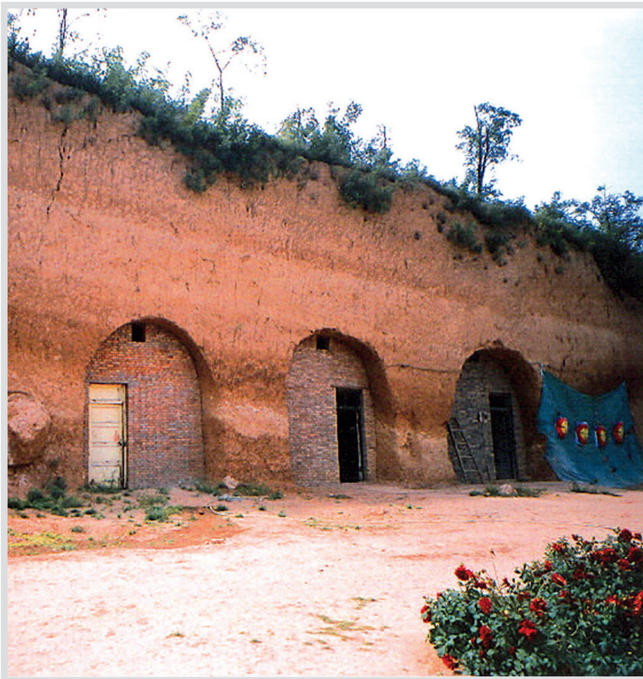
▲ Obr. 39: Hloubené příbytky a sklepy lze dodnes vidět v mnoha oblastech Sprašové plošiny. Shaanxi.
